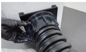
注入口の取り付け
