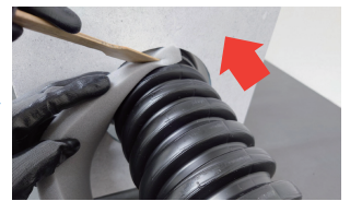
バックアップ材の切断・挿入
