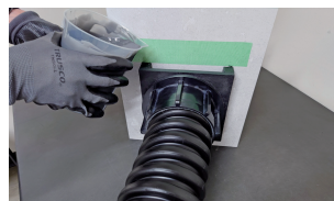
ラクシール-WG(防水材)の充填
