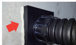
注入口の周囲は防水材の漏れ防止のため付属のパテで塞いでください(硬化後は撤去可能)
