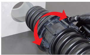
FEPにナットを取り付け貫通孔へ挿入
