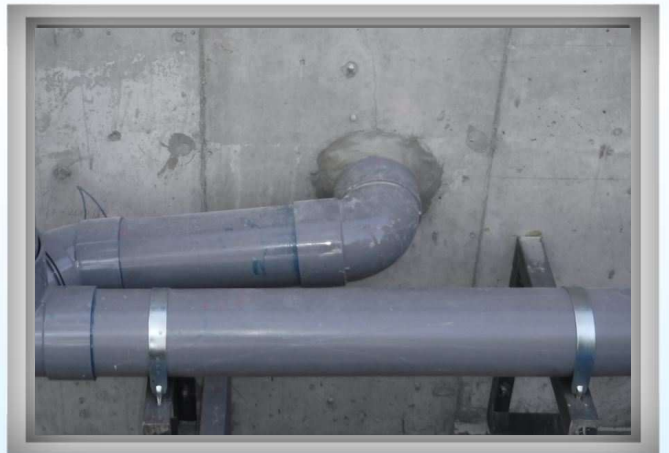
地中梁/貫通部
