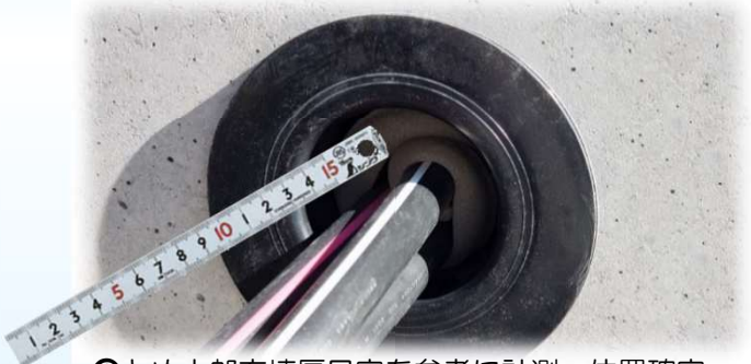
③とめ太郎充填厚目安を参考に計測、位置確定。
