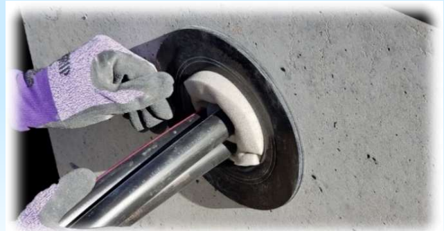
②ケーブル伝いに管路口奥側へ押し込む。
