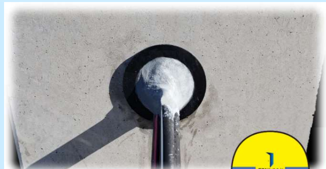
⑧CVTケーブルの場合、仕上げに撚り中央部を指先で念入りに充填し、充填作業完了。
