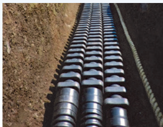
■地中ケーブル防護管 「角型エフレックス」
