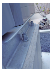
狭小箇所での 締結作業
