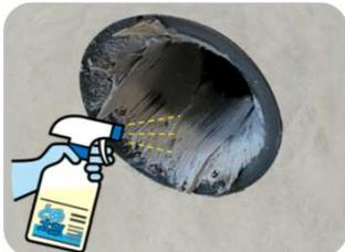
2:ピカリスターを、スプレーボトルより、直接管路口(管路凹部/ベルマウス表面)のとめ太郎に、隅々までタツプリの吹きかけます。
